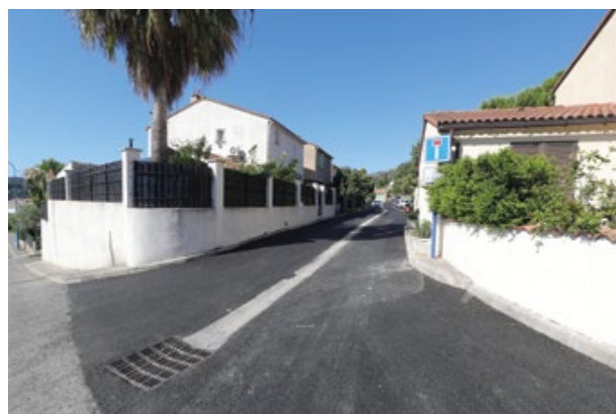
▲ RUE DU BORÉON. Travaux de voirie.
