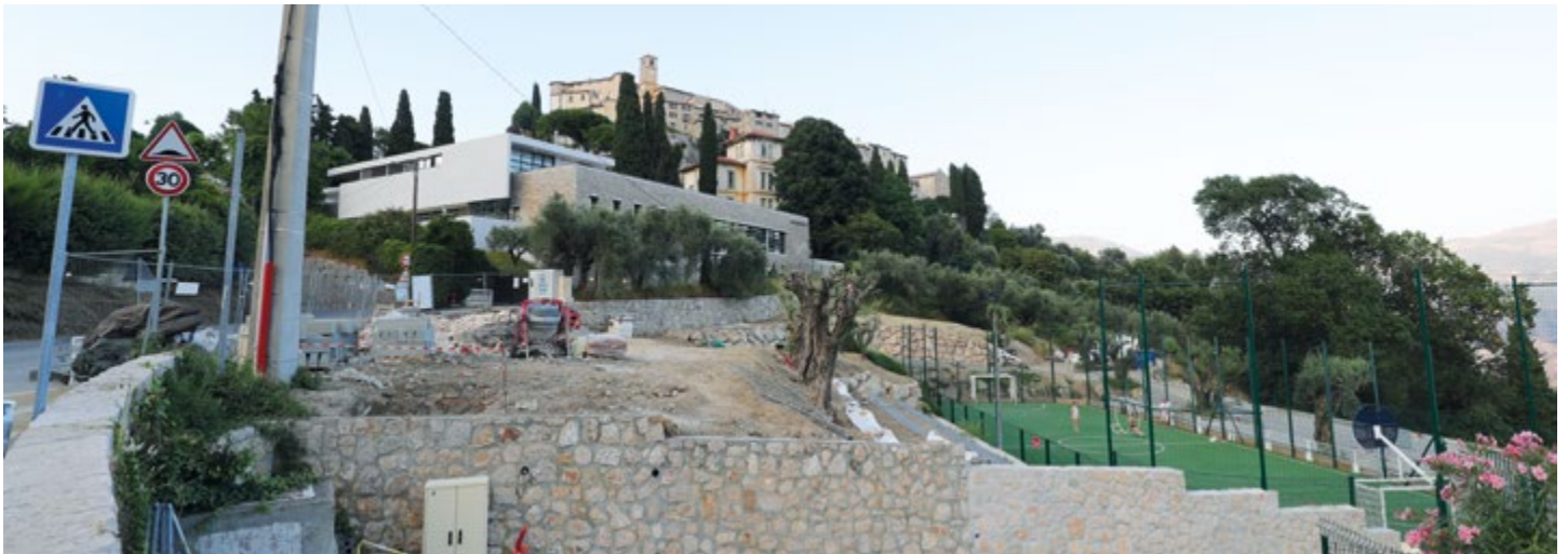
▲ PARKING DU MICROSITE DU VILLAGE. Construction en cours d'un parking de 44 places avec aménagement paysager autour du microsite du village, en contrebas de l'école Louis Fiori.
