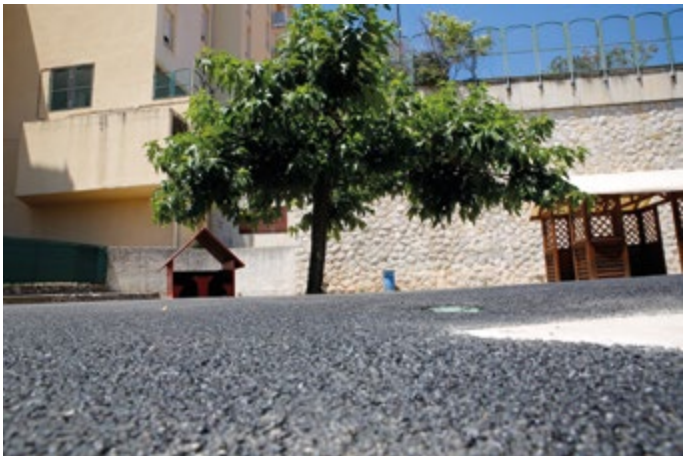
▲ MAISON DE L'ENFANCE. Reprise des enrobés et sécurisation de la cour haute.
