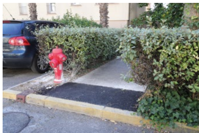
▲ IMPASSE DES BRUYÈRES. Reprise des trottoirs.
