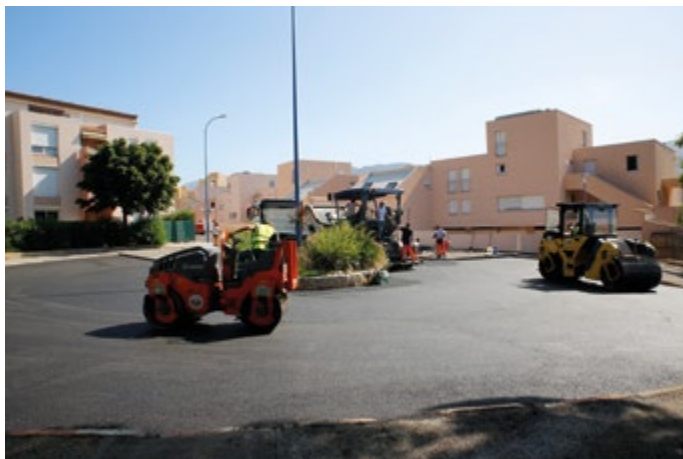
▲ RUE DES ABEILLES. Travaux de voirie.
