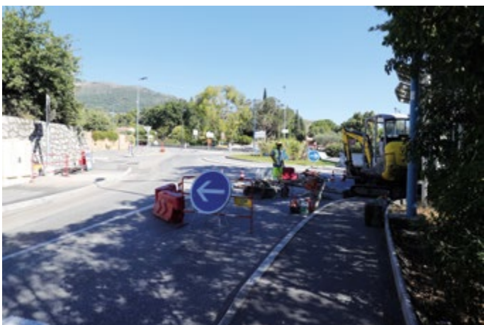
▲ ROUTE DES PLANS. Travaux de voirie et trottoirs.
